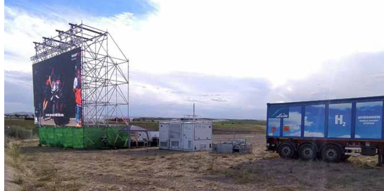
Imagen 12: FHa. Proyecto Everywh2ere-instalaciones en Motorland-2022.
