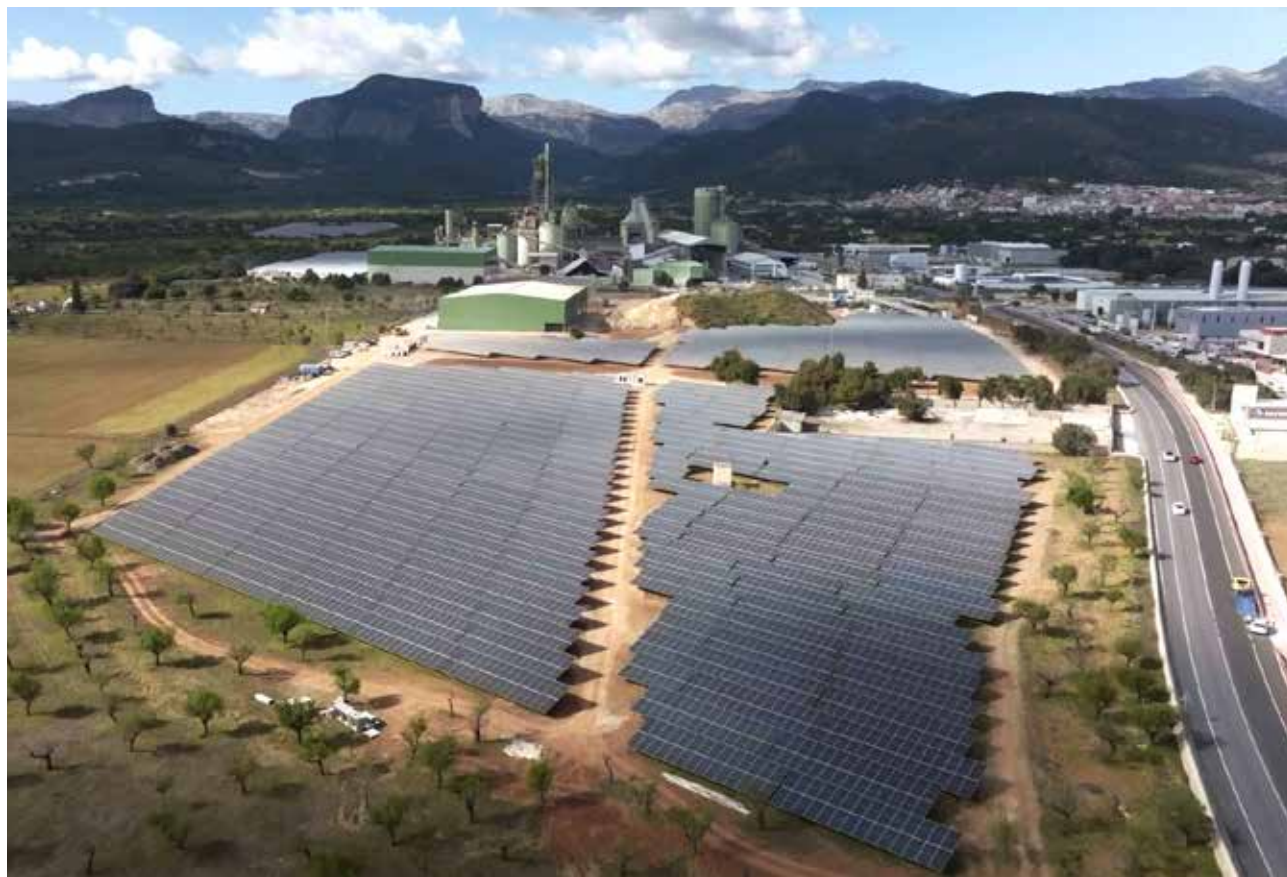
Imagen16: Acciona. Proyecto Power to Green Hydrogen Mallorca_Instalación Parque Lloseta 1.
