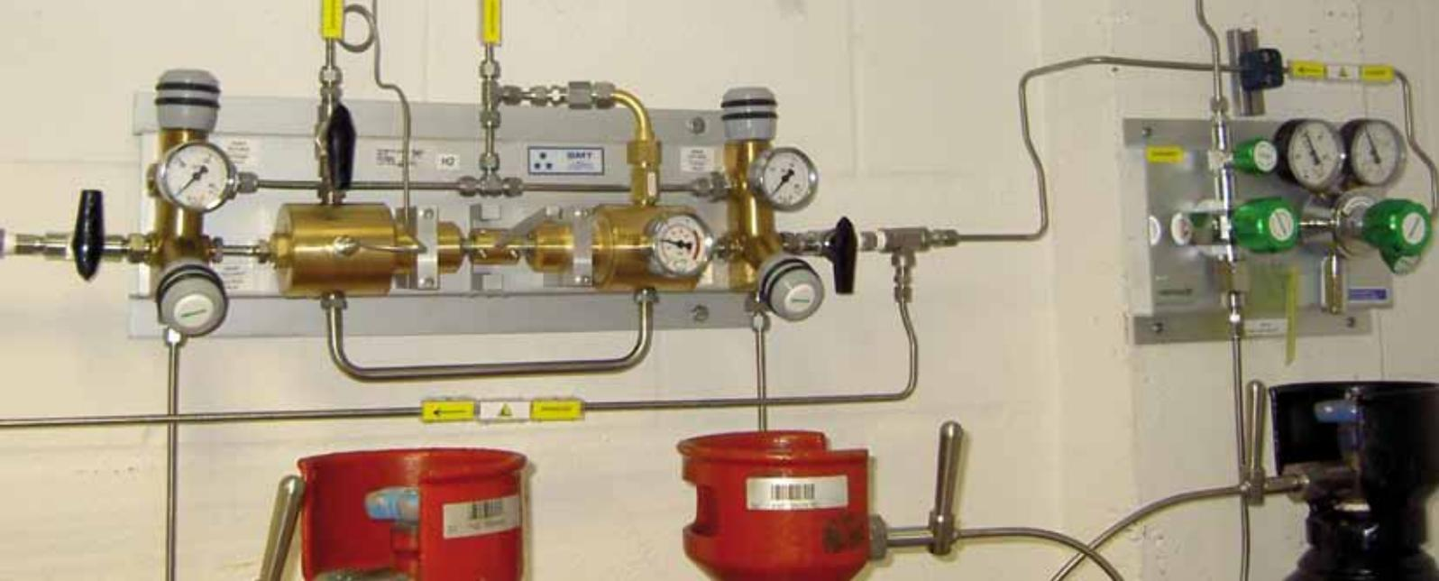
Detalle de la instalación de hidrógeno correspondiente al proyecto H2FC – Security. Cortesía de GESAN.
