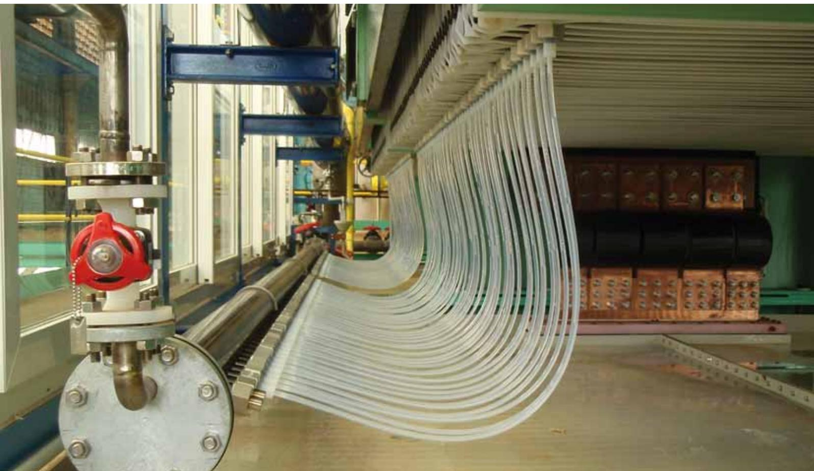
Detalle de la planta de Ercros en Sabiñánigo. Generación de hidrógeno electrolítico como subproducto del proceso de producción cloro – álcali.
