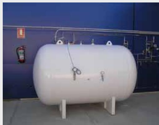
Depósito de almacenamiento de hidrógeno desarrollado por la empresa Lapesa que forma parte de la estación de servicio de hidrógeno instalada en el Parque Tecnológico Walqa.
