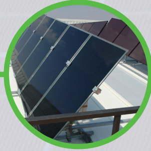
PANELES CAPA DELGADA. 0,7 kWp Thin layer cells PANELES AMORFOS. 1 kWp Amorphous cells
